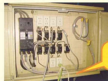
配電盤(分電盤)の金属製構造物に接地極が施されていなかったもの。
