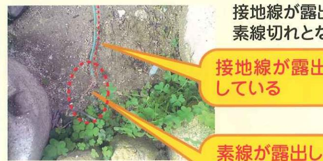
接地線が露出していたため、接地線が引っ掛けられ、素線切れとなっていたもの。
