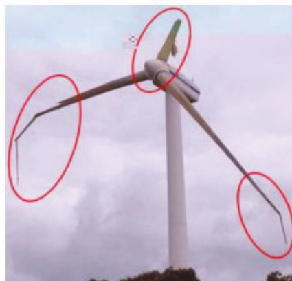
雷撃を受けた風車ブレードの折損事故
