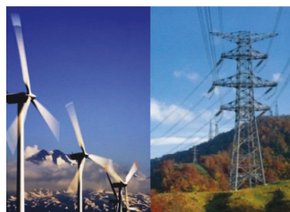
風車・電線・鉄塔
