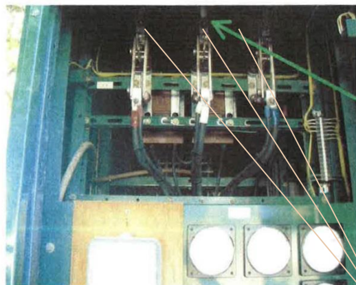
短絡接地取付箇所 「DS 一次側」
