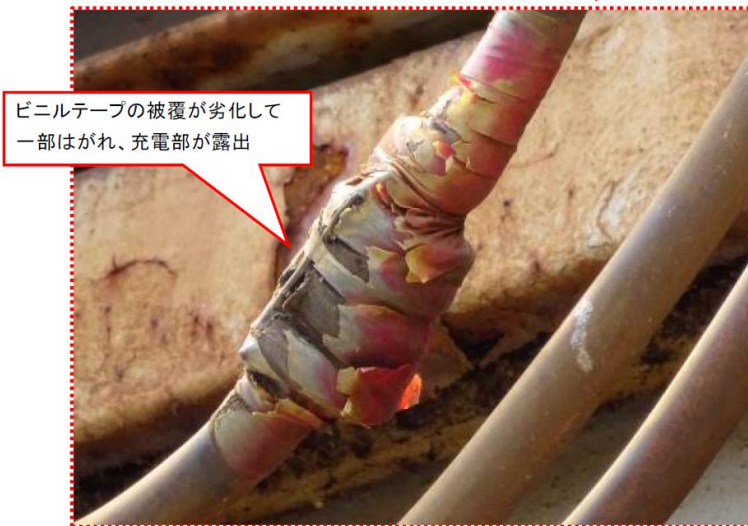
ケーブル接続部（拡大）
