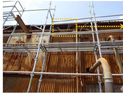
事故現場周辺
