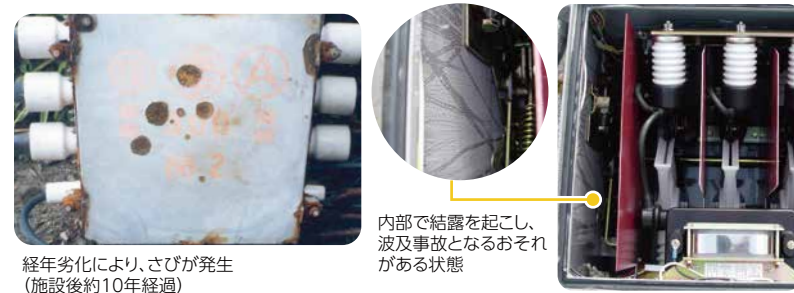
経年劣化により、さびが発生(施設後約10年経過) 内部で結露を起し、波及事故となるおそれがある状態
