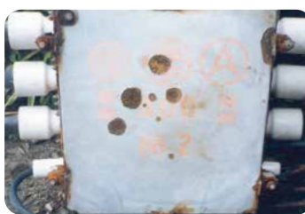
経年劣化により、さびが発生(施設後約10年経過)
