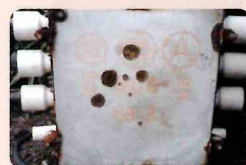
経年劣化により、さびが発生(施設後約10年経過)
