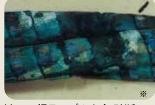
遮へい銅テープの腐食・破断
