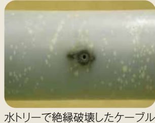
水トリーで絶縁破壊したケーブル
