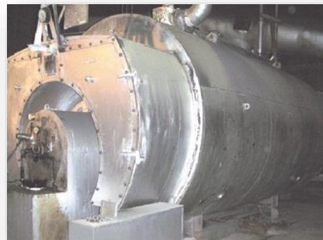
ボイラーの保温材 (出典:国土交通省 目で見えるアスベスト建材)
